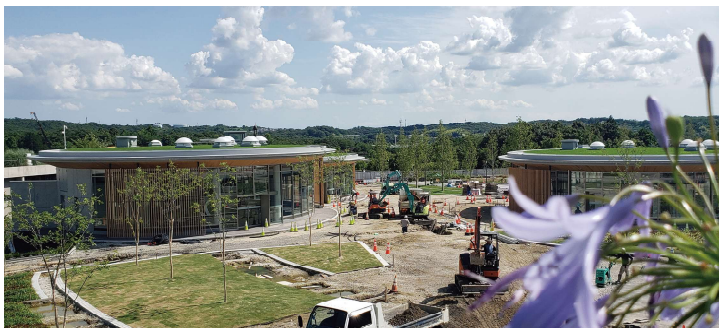
着々と進むジブリパークの整備
