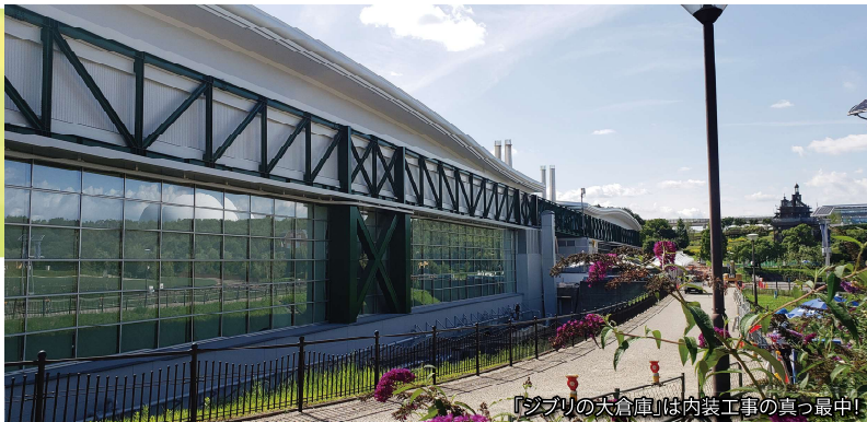
「ジブリの大倉庫」は内装工事の真っ最中!
